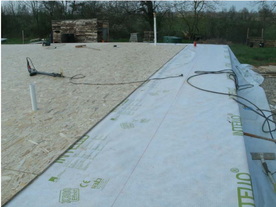
Pose du frein vapeur + de l'OSB rainure languette
