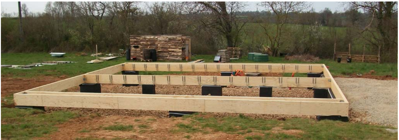
Pose des ceinture Kerto (ou lamellé collé), y compris refend intérieure
