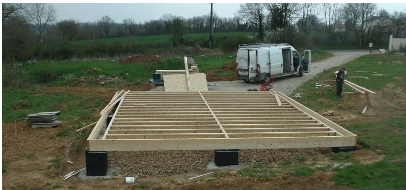
Pose des poutres en I pour remplissage
