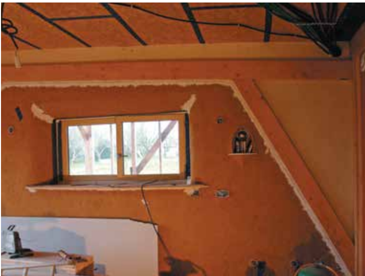
Le mur est à différents stades d'avancement : Au centre, le corps d'enduit avec deux fissures couvertes d'adhésif. A droite, l'enduit de finition crème est commencé.
