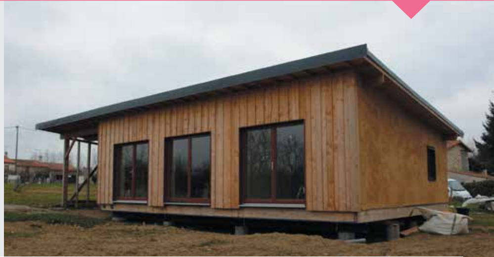
Le test démontre la viabilité de ce système constructif, particulièrement économique à moins de 2000 €/m 2 , clé en main, avec des matériaux locaux et une charpente traditionnelle.
